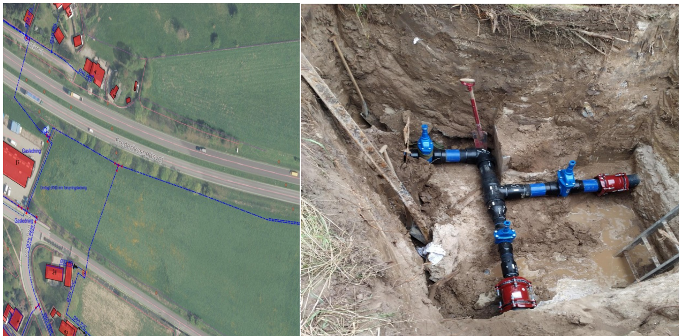
"Pouls mark" udskiftning af 3 ventiller
