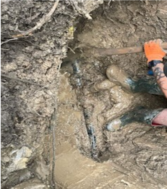
Lækagen på vandtårnet, omkring lækagen er jorden meget våd. På kildevej har vi fundet og fået repareret lækagen
