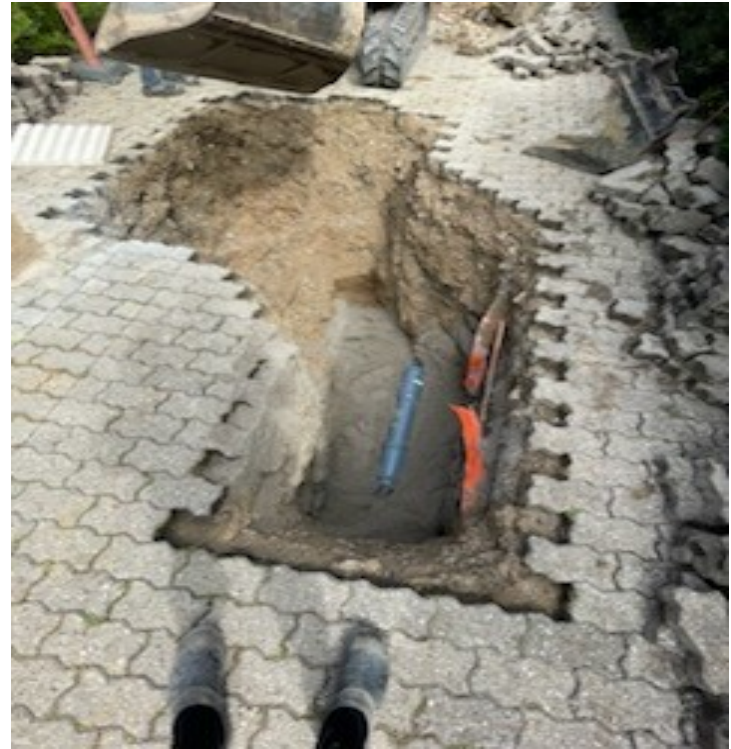
Lækagen på vandtårnet, omkring lækagen er jorden meget våd. På kildevej har vi fundet og fået repareret lækagen
